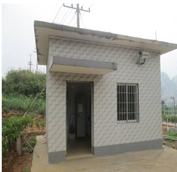
生活污水出水在线监测房
