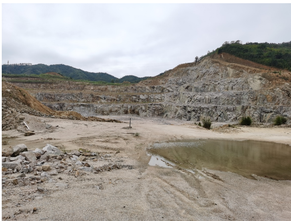
图 3-1 项目区现场照片
