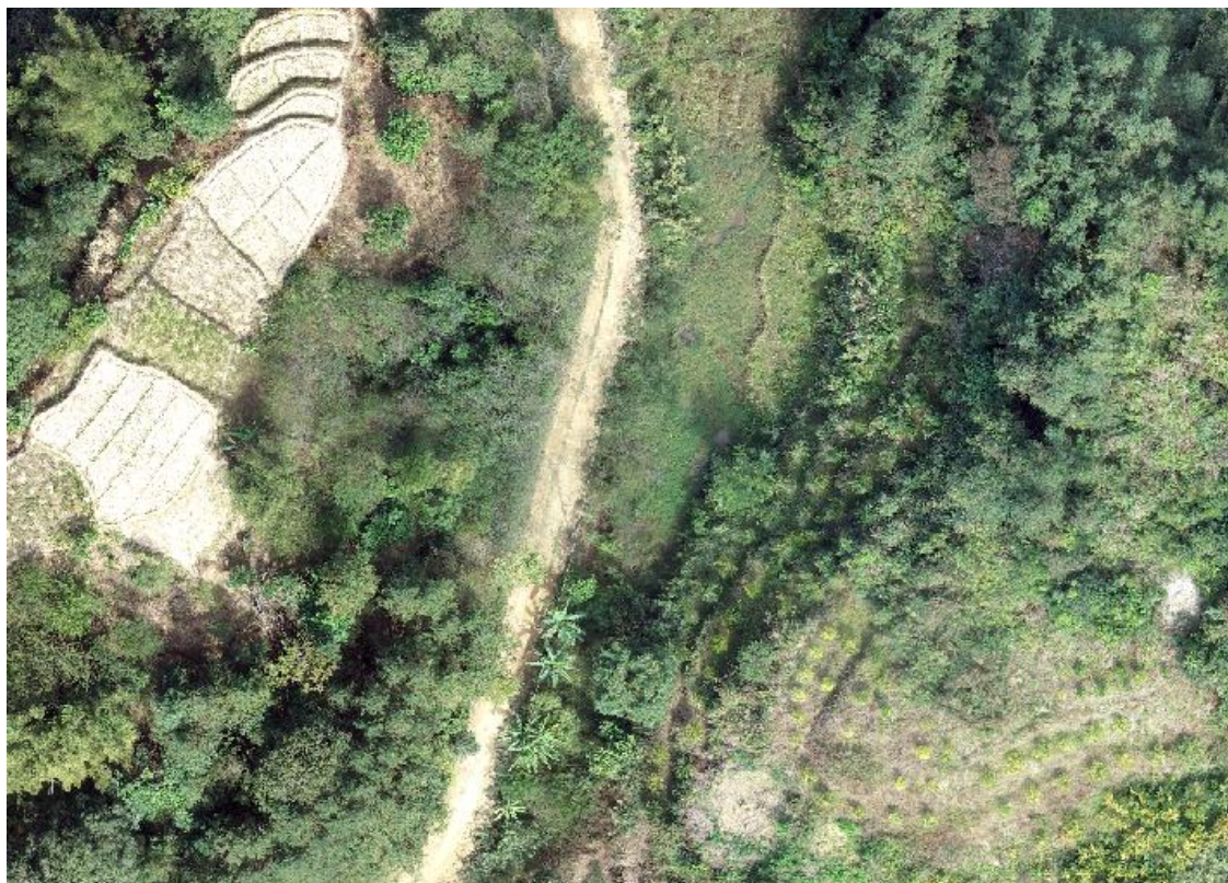
临时用地现场照片(施工便道)
