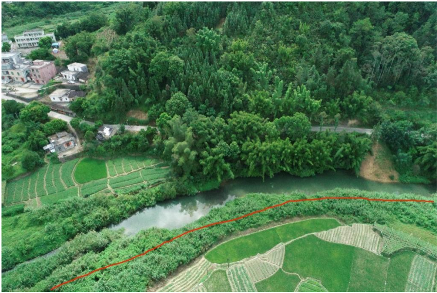
图4-5 踏勘现场照片
