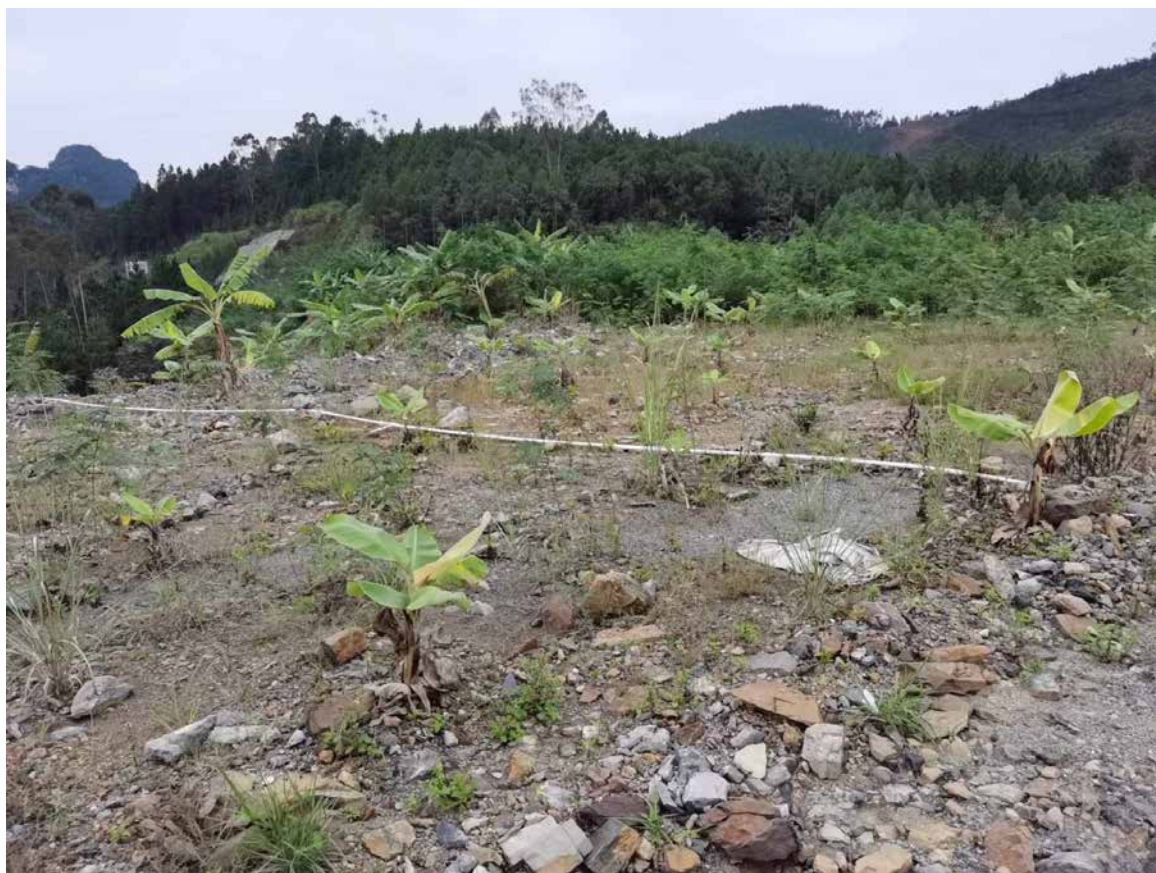
临时用地现场照片(材料堆场)
